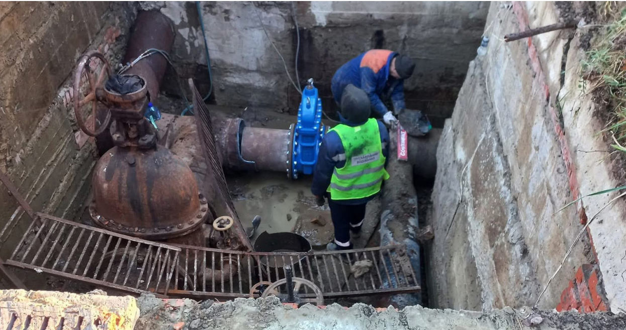
Рис. 32 Заміна водозапірної арматури на резервуарі «Колиба», грудень 2024 Джерело: Трускавецька міська рада
